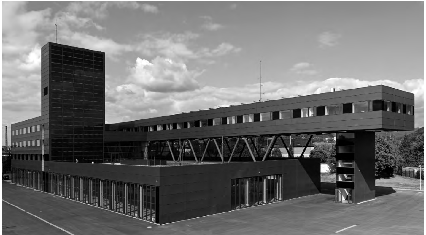
Feuerwehrwache Heidelberg, Heidelberg/D
