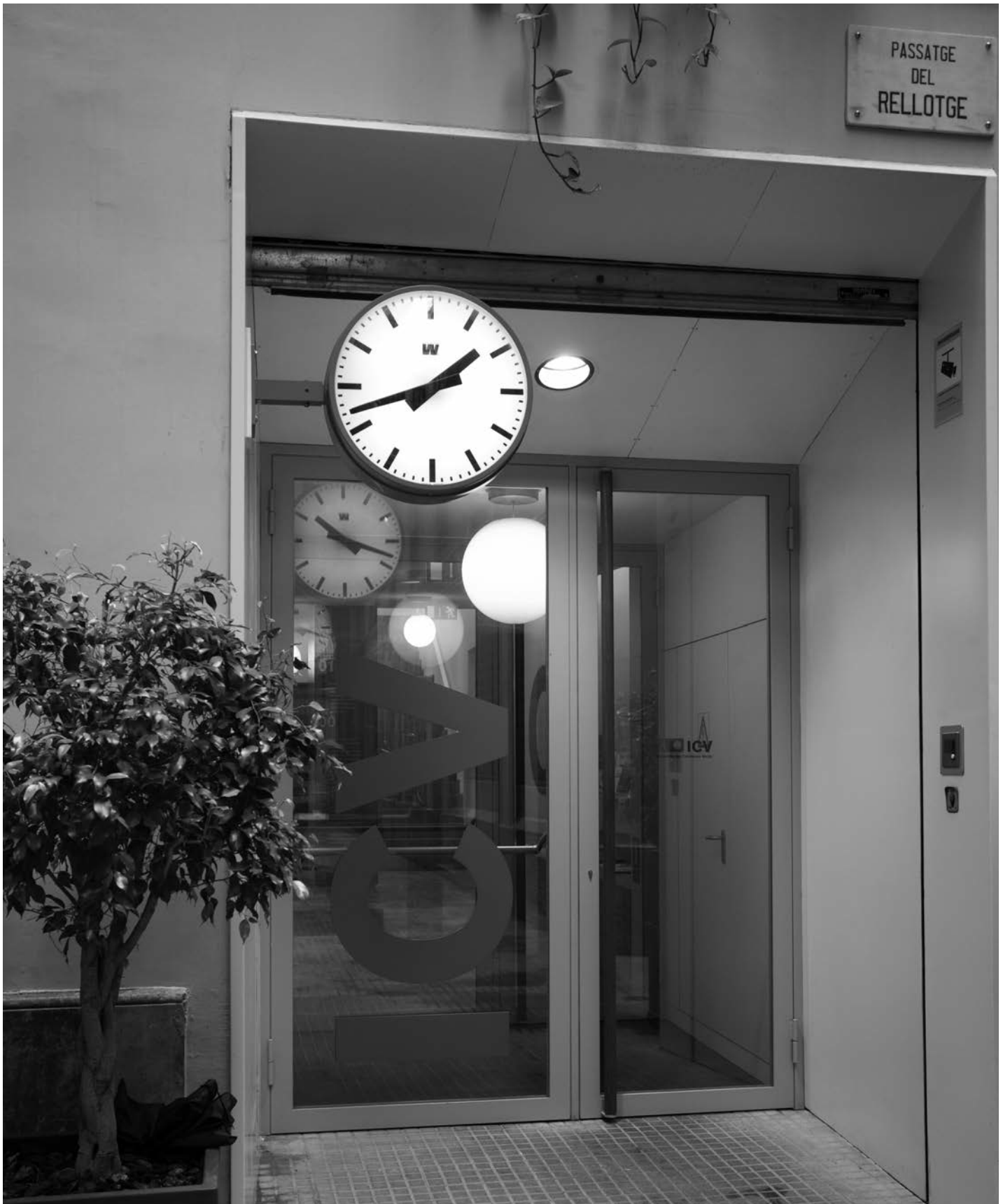
Verwaltungsgebäude ICV, Barcelona/ES (Bopbaa slp, Arquitectura, Barcelona/ES)
