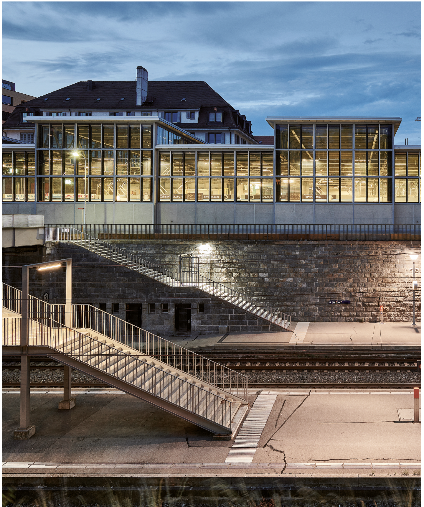
VBZ Tramdepot Kalkbreite, Zürich/CH (Architekt: Ernst + Hummel GmbH, Zürich/CH)
