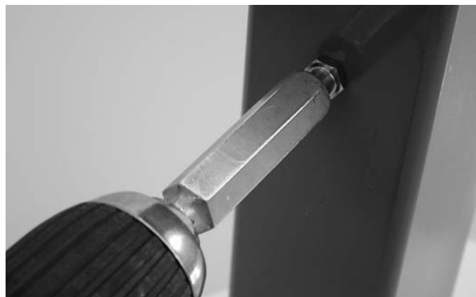
Abb. 26 Anziehen der Schraubbolzen resp. Schraub-Traganker mit Akku-Bohrschrauber (Drehmoment ca. 4-5 Nm) Ill. 26 Serrage des goujons à visser resp. des boulons- supports à visser avec visseuse à accumulateur (couple env. 4-5 Nm)
