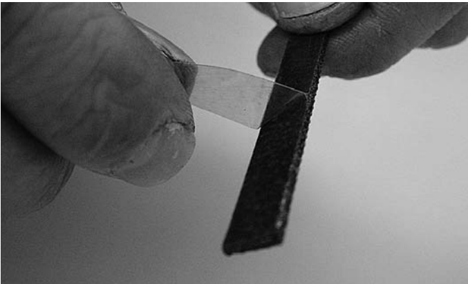
Abb. 83 Schutzfolie bei Brandschutzlaminat-Streifen ein Stück weit abziehen Fig. 83 Retirer un peu le film protecteur sur la bande de protection-incendie
