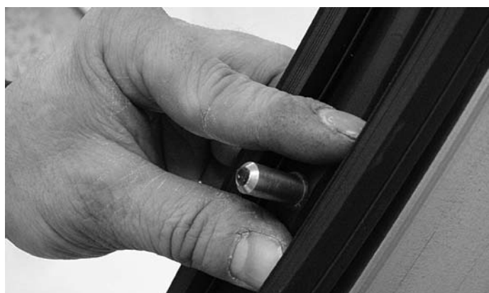
Abb. 32 Dichtung andrücken
