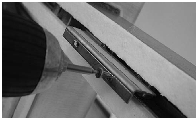
Abb. 19 Einsetzen und Befestigen der Glasauflagen mittels Schraube, auf Brandschutzanker zur Feldmitte Fig. 19 Insérer les supports de verre et les fixer avec une vis sur le boulon d'ancrage anti-incendie vers le milieu du champ
