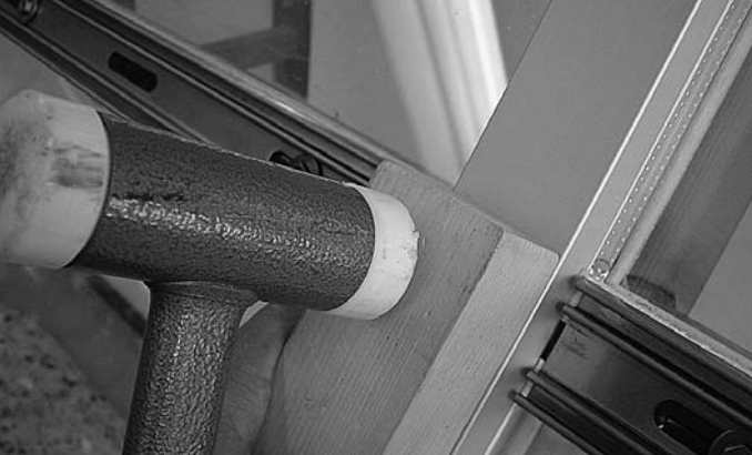
Abb. 30 Aufschlagen der Abdeckprofile mit Schutzholz und Nylonhammer Fig. 30 Frappe des profilés de recouvrement avec bois de protection et marteau en nylon
