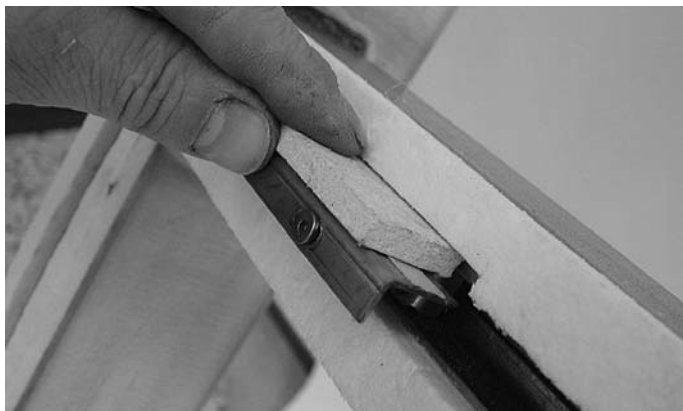
Abb. 21 Glasklotz auflegen und satt andrücken Fig. 21 Poser la cale et bien appuyer
