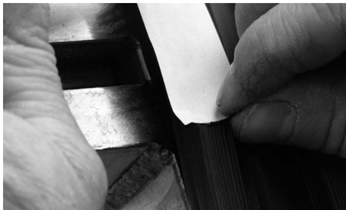
Abb. 55 Butyl-Dichtstück unten in der Ausklinkung ausrichten
