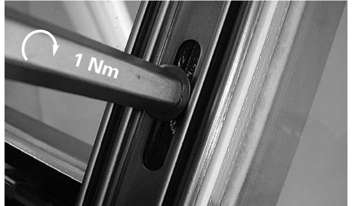
Abb. 27 Anpressprofil mittels Zentrier Mutter und Spezialschlüssel 499.254 anziehen, Drehmoment 1 Nm.
