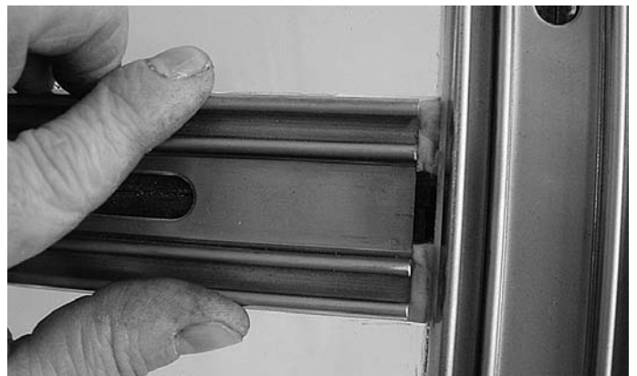
Abb. 29 Horizontales Anpressprofil anlegen. Seitliches Spiel gleichmässig verteilen.
