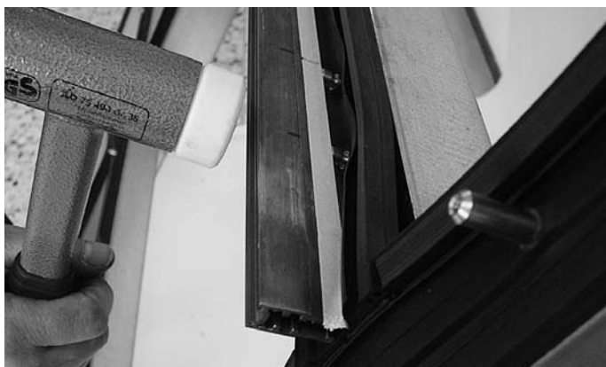
Abb. 68 Riegel-Falzprofil ausrichten und mit Nylon-Hammer aufklipsen Fig. 68 Orienter profilé de feuillure traverse et clipser avec marteau en nylon
