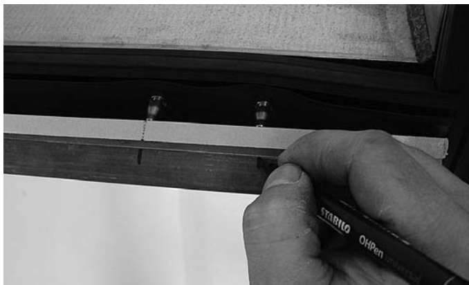
Abb. 67 Position der Traganker auf dem Riegel-Falzprofil markieren Fig. 67 Marquer la position des boulons-soutiens sur le profilé de feuillure traverse
