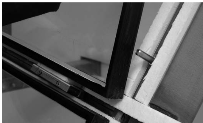
Abb. 22 Füllelement auf Glasauflagen absetzen und oben anlegen Fig. 22 Poser l'élément de remplissage sur les supports de verre et les placer en haut
