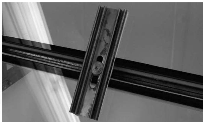
Abb. 25 Füllelement mit Anpressprofil-Stück sichern Fig. 25 Assurer l'élément de remplissage avec la pièce du profilé de fixation
