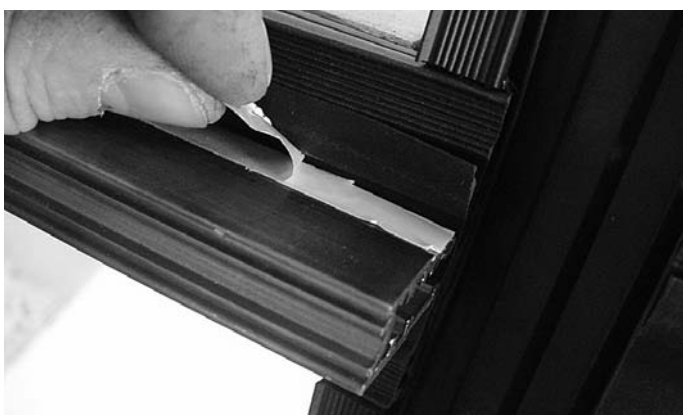
Abb. 70 Klebeband-Schutzfolie abziehen Fig. 70 Retirer la feuille de protection de la bande adhésive
