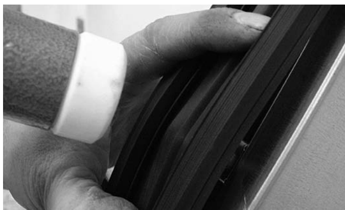
Abb. 32 Aufschlagen der Dichtung mittels Nylonhammer
