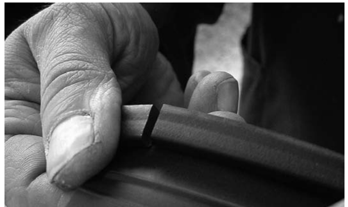
Abb. 47 Abgelängte und gleichzeitig rückseitig eingeschnittene Riegeldichtung
