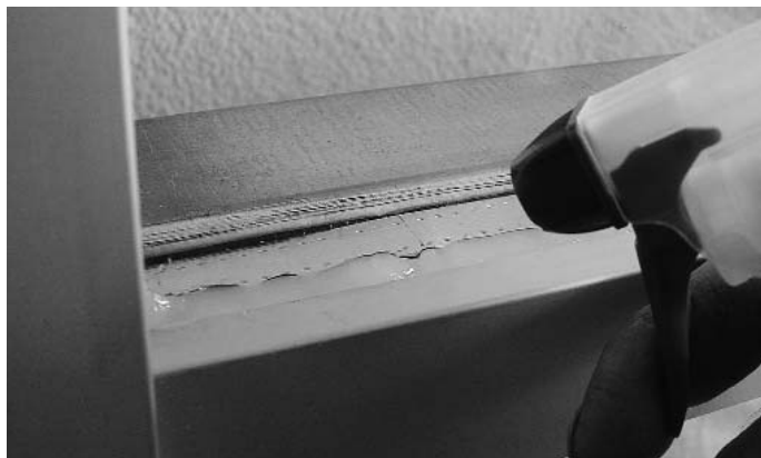
Abb. 37 Dichtstoff-Fuge mit Abglättmittel besprühen Fig. 37 Humecter le joint d'étanchéité avec de l'eau savonneuse
