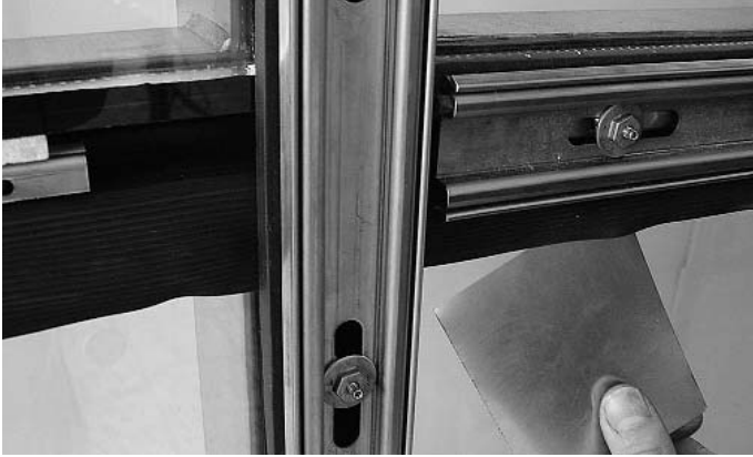
Abb. 37 Schneidunterlage (z.B. Inox-Blech 0,5 mm) unter Dichtungslappen schieben Fig. 37 Pousser un support de coupe (ex: tôle Inox de 0,5 mm) sous la languette
