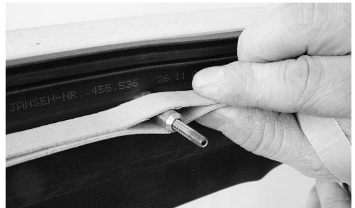
Abb. 50 Brandschutzlaminat im Bereich Brandschutzanker
