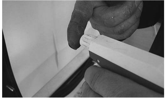
Abb. 15 Zeigfinger mit Seifenwasser benetzen um die aufgetragene Dichtmasse* verstreichen zu können.
