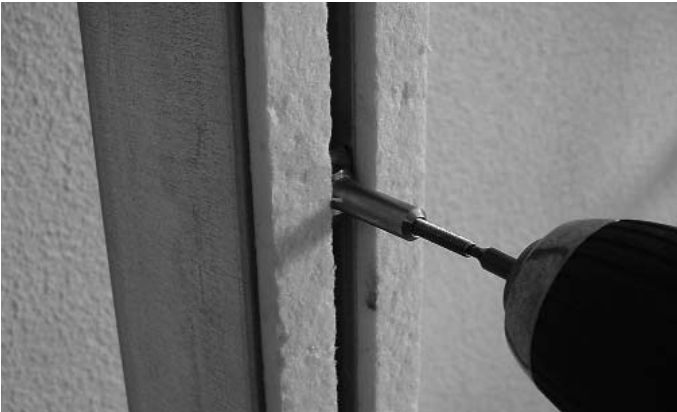
Abb. 10 Eindrehen der M4-Gewindestifte in Brandschutzanker vertikal (Pfostenbereich) Fig. 10 Ancrage de la vis sans tête M4 dans le boulon d'ancrage anti-incendie vertical (zone du montant)
