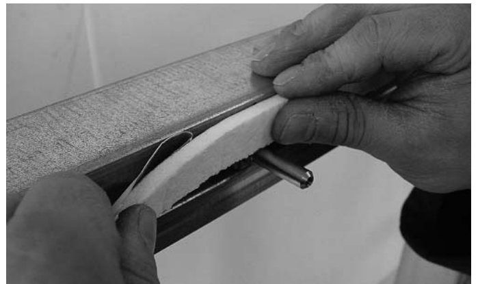
Abb. 2 Keramikfaserband auf Riegel setzen und andrücken Fig. 2 Poser la bande de fibre de céramique sur la traverse et appuyer
