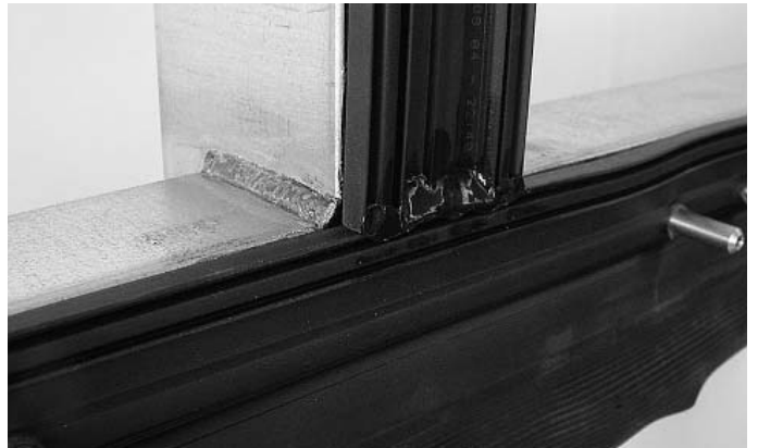
Abb. 17 Abgedichteter Dichtungsstoss im Riegelbereich oben
