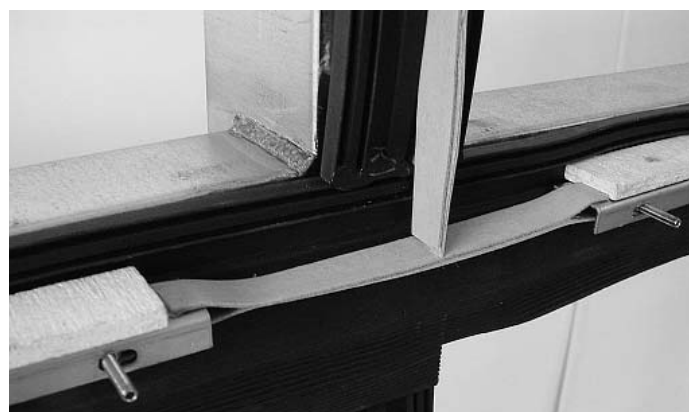
Abb. 52 Vertikales Brandschutzlaminat zwischengesetzt
