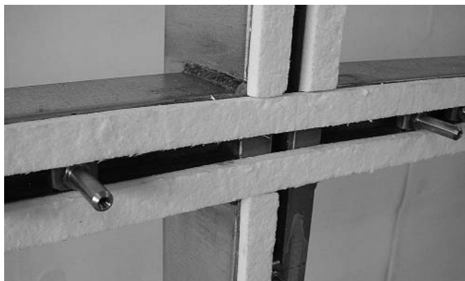
Abb. 6 Die vertikalen Keramikfaserbänder werden im Kreuzpunkt-Bereich zwischengesetzt. Fig. 6 Les bandes de fibre de céramique verticales sont intercalées dans la zone du point de croisée.
