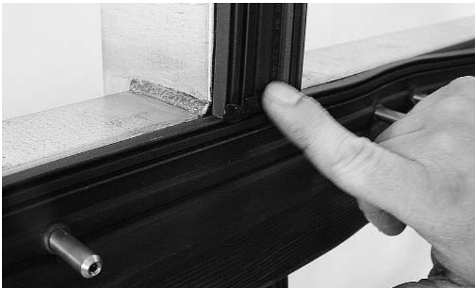
Abb. 16 Ausstreichen der Dichtmasse* im Bereich Vertikal-/ Horizontaldichtung
