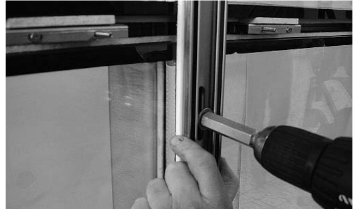
Abb. 20 Vertikale Anpressprofile anlegen und festschrauben Fig. 20 Poser les profilés de fixation verticaux et visser à fond
