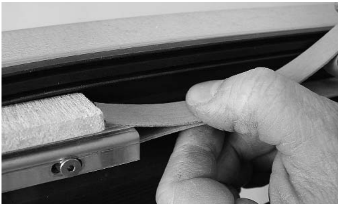
Abb. 49 Brandschutzlaminat oben zwischen Glasauflegern/ Glasklötzen ankleben.
