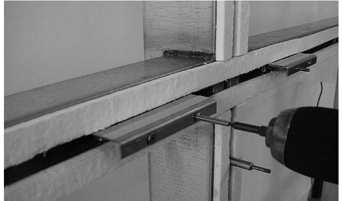
Abb. 13 Eindrehen Gewindestift bei Glasauflagen Fig. 13 Ancrage de la vis sans tête pour les supports de verre
