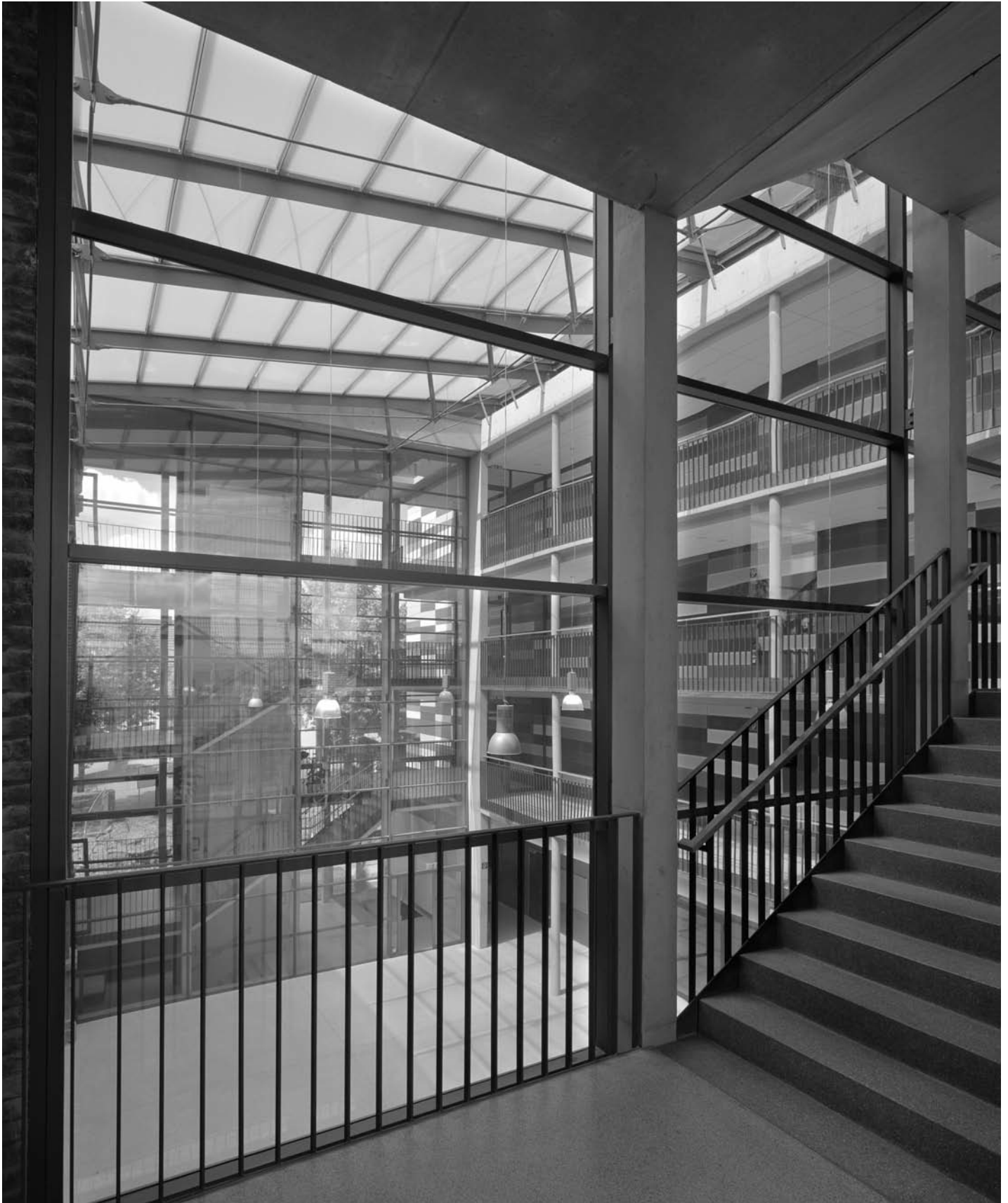
Brüder-Grimm-Schule, Hofgeismar/DE (Architekt: Roller Krahl Architekten BDA, Kassel/DE)
