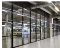
62 Ausbau Messehalle BEA Expo, Bern/CH
