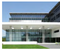
12 Büro- und Geschäftshaus «Hillsite», Schwalbach am Taunus/DE
