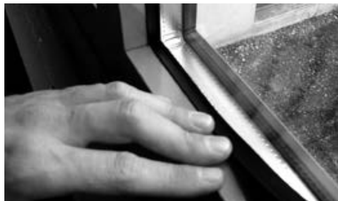
Einbau der Innendichtung Montage du joint intérieur Fitting the interior weatherstrip
