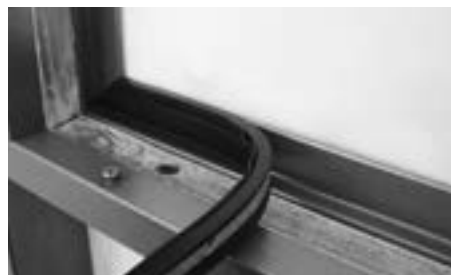
Aussendichtung montieren Monter le joint extérieur Installing the outer weatherstrip
