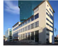
6 Umbau Bürogebäude «Diagonal», Zürich/CH
