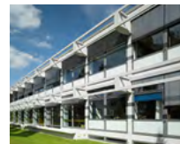
15 Universität Saarbrücken, Gebäude B41, Saarbrücken/DE.
