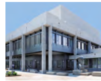
24 Universität St.Gallen, St.Gallen/CH
