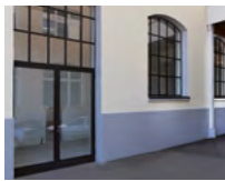
28 Heizhaus Brosswaldengasse, Bregenz/AT
