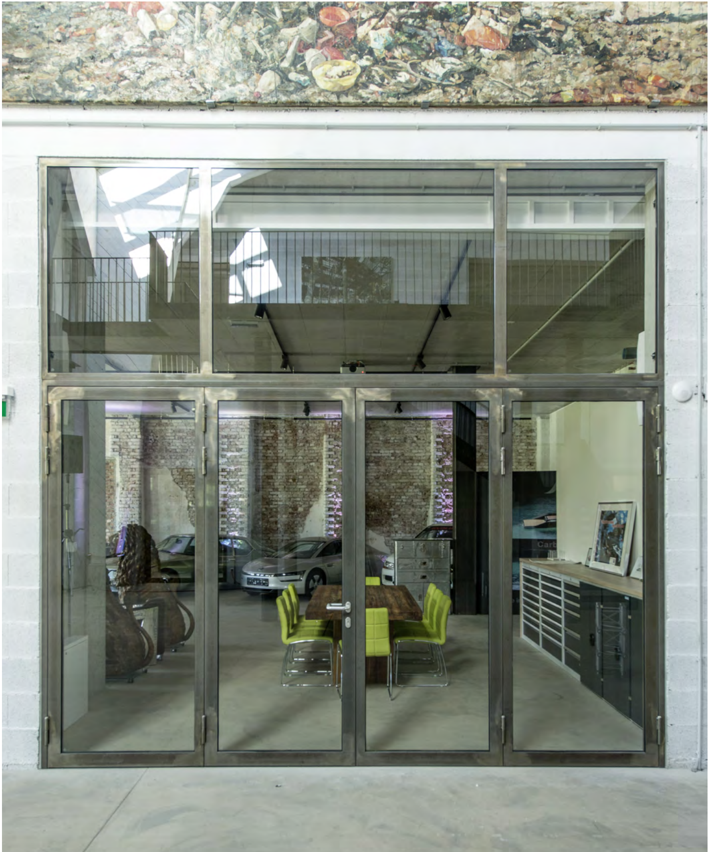
Panzerhalle, Salzburg/AT (Architekt: ARGE LP Architectur/CS-Architektur/Strobl Architekten)
