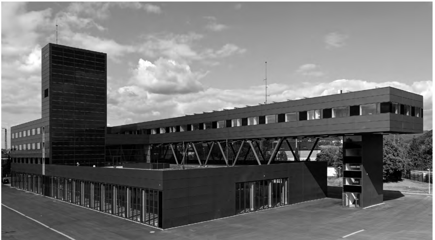
Feuerwehrwache Heidelberg, Heidelberg/D
