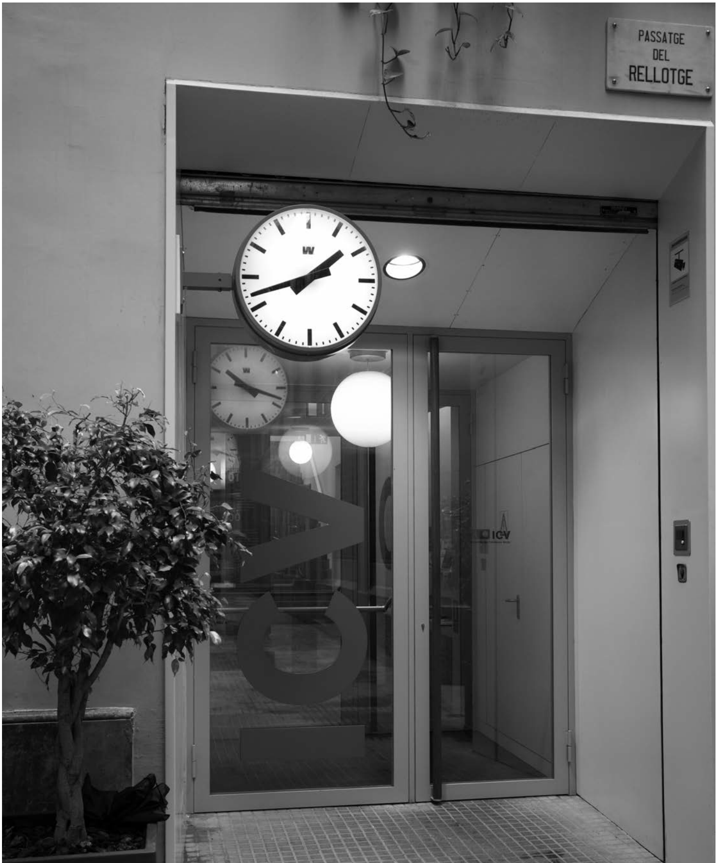
Verwaltungsgebäude ICV, Barcelona/ES (Bopbaa slp, Arquitectura, Barcelona/ES)
