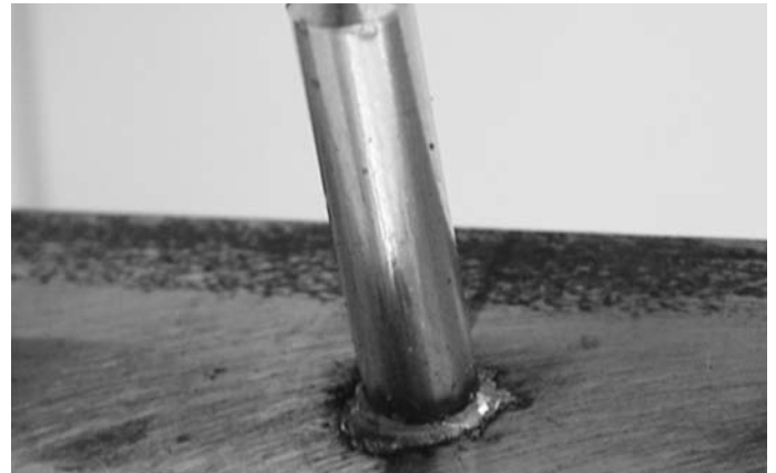
Abb. 10 Prüfung der Schweiss-Stelle durch Sichtkontrolle (umlaufend sauberer, gleichmässiger Schweisswulst) III. 10 Vérification de la soudure par contrôle visuel (entourage propre, cordon régulier)
