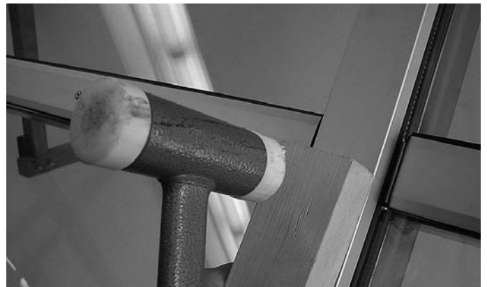
Abb. 107 Aufschlagen der vertikalen Abdeckprofile mit Schutzholz und Nylonhammer Fig. 107 Monter les profilés de recouvrement verticaux avec le bois de protection et le marteau en nylon
