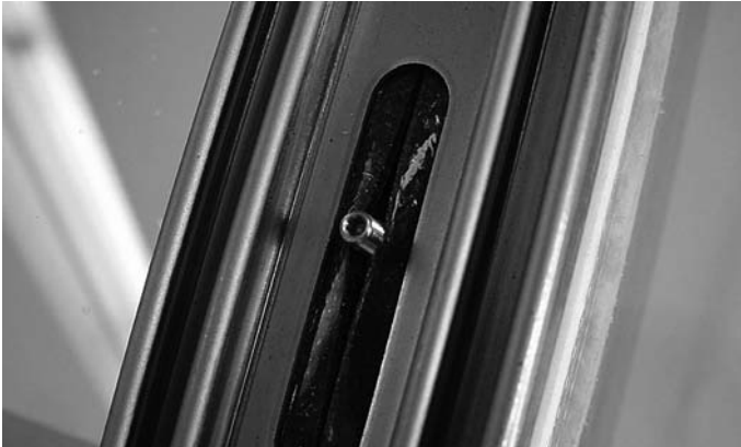
Abb. 26 Anpressprofile im Bereich der Langlöcher über die Gewindestifte drücken Fig. 26 Presser les profilés de fixation dans la zone des trous oblongs sur les vis sans tête
