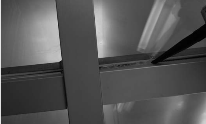
Abb. 32 Silikonmasse in die Fuge pressen Fig. 32 Presser la masse de silicone dans le joint
