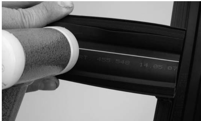
Abb. 51 Mit Nylonhammer aufschlagen/perforieren Fig. 51 Perforer avec le marteau en nylon
