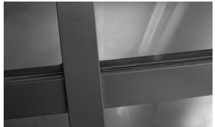
Abb. 35 Versiegelte Fuge Fig. 35 Joint jointoyé
