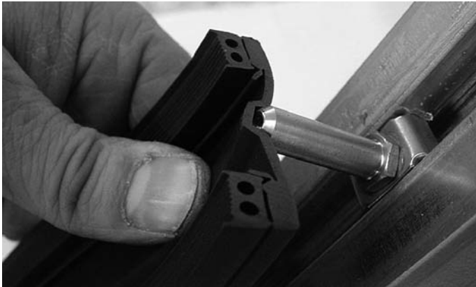
Abb. 30 Zentrierung durch Führungsnute auf Rückseite der Dichtung
