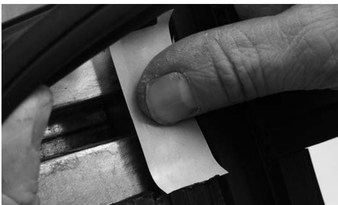
Abb. 56 Butyl-Dichtstück U-förmig eindrücken
