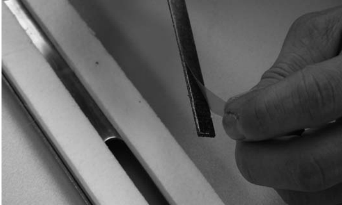
Abb. 15 Schutzfolie bei Brandschutzlaminat-Streifen ein Stück weit abziehen Fig. 15 Retirer un peu le film protecteur pour la bande de protection-incendie
