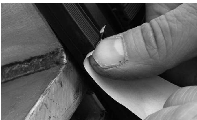
Abb. 54 Butyl-Dichtstück oben in der Ausklinkung ausrichten
