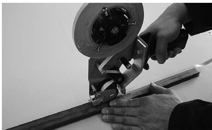
Abb. 65 Klebeband mit Dispenser auftragen Fig. 65 Appliquer la bande adhésive avec le dérouleur
