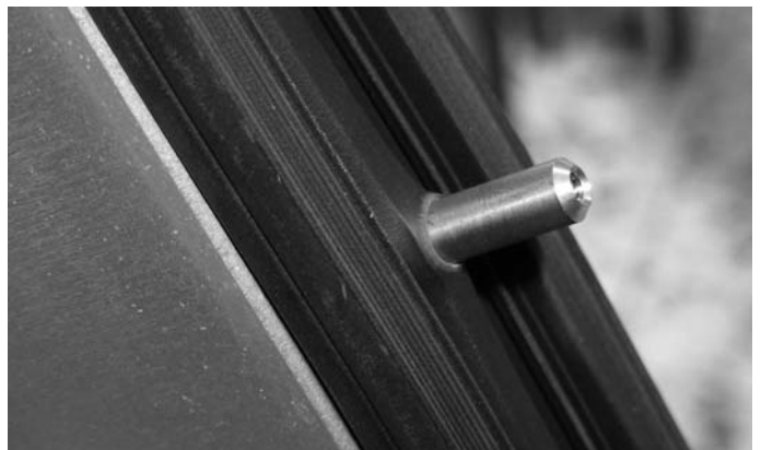
Abb. 33 Leichte Wölbung im Bereich der Brandschutzanker
