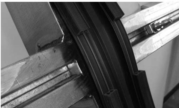
Abb. 38 Ausgeklinkte Kreuzpunkt-Dichtung Fig. 38 Joint de point de croisée entaillé
