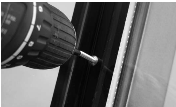
Abb. 93a Im Sparrenbereich M5-Gewindestifte in Brandschutzanker eindrehen Fig. 93a Dans la zone de chevron d'ancrage de la vis sans tête M5 dans le boulon d'ancrage anti-incendie
