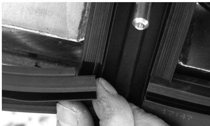
Abb. 50 Platzieren der Horizontaldichtung im Kreuzpunkt Fig. 50 Positionner le joint horizontal au point de croisée
