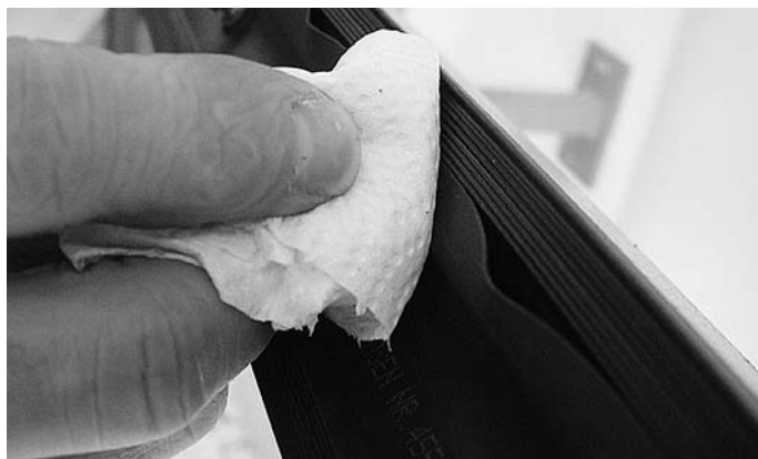
Abb. 66 Dichtungslappen der Horizontaldichtung mit Primer reinigen Fig. 66 Nettoyer les languettes du joint intérieur horizontal avec le primaire
