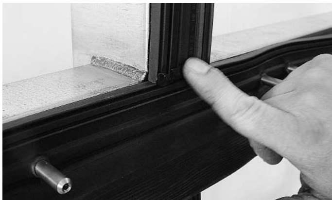
Abb. 16 Ausstreichen der Dichtmasse* im Bereich Vertikal-/ Horizontaldichtung
