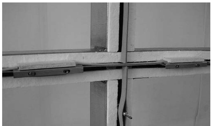
Abb. 34 Vertikales Brandschutzlaminat zwischengesetzt
