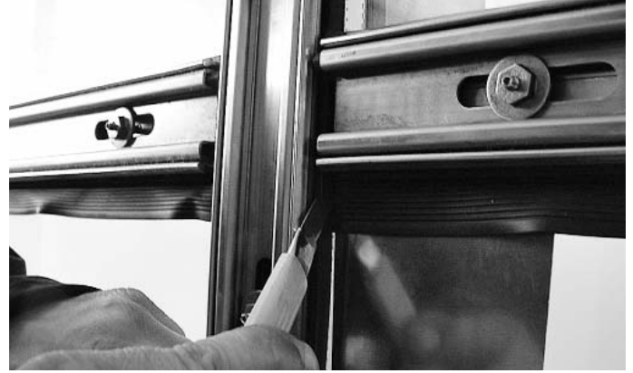
Abb. 38 Dichtungslappen entlang dem vertikalen Anpressprofil links und rechts anschneiden Fig. 38 Découper la languette le long du profilé de fixation vertical
