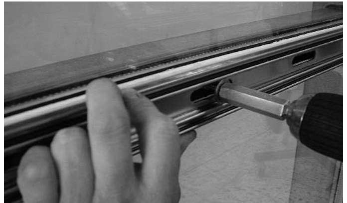
Abb. 22 Horizontales Anpressprofil festschrauben. Anziehen mit Spezialschlüssel 499.254, Drehmoment 1 Nm. Fig. 22 Visser le profilé de fixation horizontal à fond. Serrage avec clé spéciale 499.254, couple de serrage 1 Nm.
