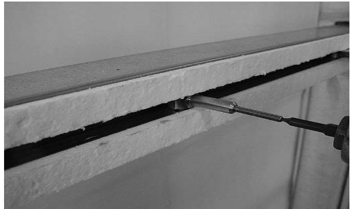
Abb. 11 Eindrehen der Gewindestifte in Brandschutzanker horizontal (Riegelbereich) Fig. 11 Ancrage de la vis sans tête dans le boulon d'ancrage anti-incendie horizontal (zone de la traverse)
