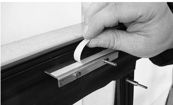
Abb. 28 Abziehen der Klebeband-Schutzfolie bei Glasauflagen Fig. 28 Enlèvement du film protecteur adhésif pour les supports de verre
