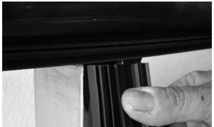
Abb. 13 Dichtung anlegen und satt andrücken
