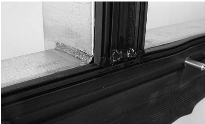
Abb. 17 Abgedichteter Dichtungsstoss im Riegelbereich oben
