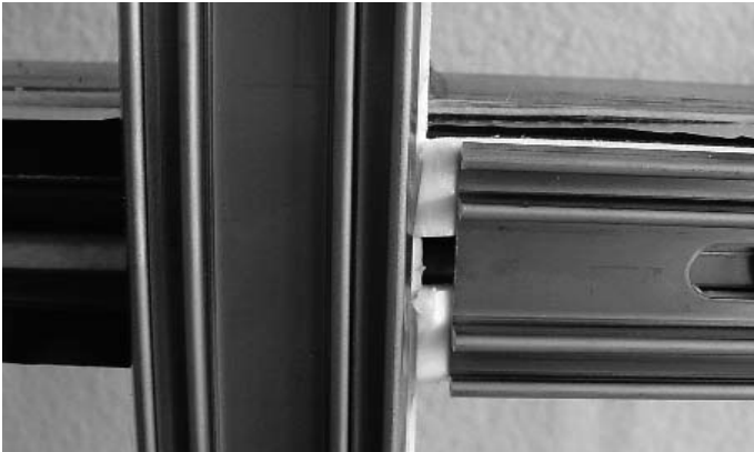
Abb. 21 Horizontales Anpressprofil anlegen und darauf achten, dass das Spiel beidseitig gleichmässig verteilt ist. Fig. 21 Poser le profilé de fixation horizontal. Veiller à ce que le jeu soit réparti régulièrement des deux côtés.
