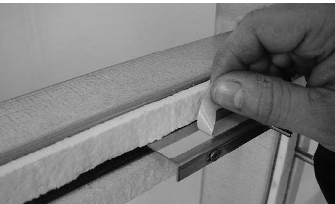
Abb. 14 Abziehen der Klebband-Schutzfolie Fig. 14 Enlèvement du film protecteur adhésif de la bande adhésive
