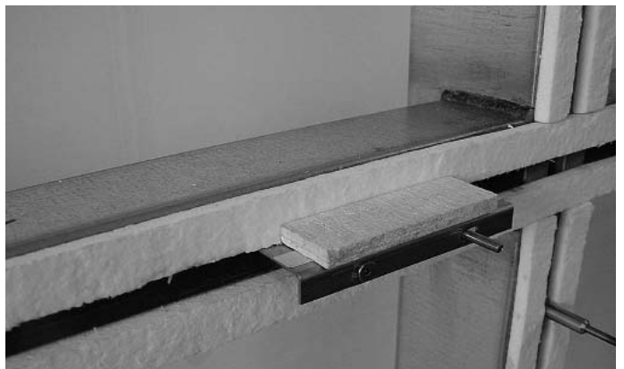
Abb. 15 Glasklotz auflegen und satt andrücken Fig. 15 Poser la cale et bien appuyer
