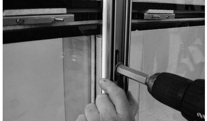
Abb. 20 Vertikale Anpressprofile anlegen und festschrauben Fig. 20 Poser les profilés de fixation verticaux et visser à fond
