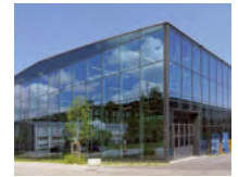
66 Werkhalle Glas Trösch, St.Gallen/CH
