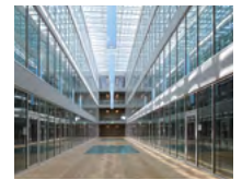
18 Universität Lausanne «Géopolis», Lausanne/CH
