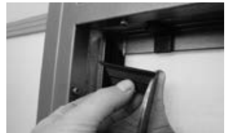
Freistellen im Bereich Belüftungswinkel Interruption dans la zone équerre d'aération Freeing in the region of the angle for glazing rebate ventilation
