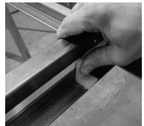
Belüftungswinkel aufstecken Monter l'équerre de ventilation Plugging-in the angle for glazing rebate ventilation
