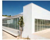
5 Hauptschule Lima de Freitas, Setubal/PT
