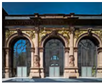
18 Renovation «Alte Post», Pirmasens/DE
