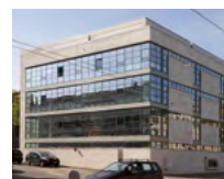
40 Geschäftshaus, Zürcherstrasse, St.Gallen/CH
