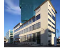
6 Umbau Bürogebäude «Diagonal», Zürich/CH
