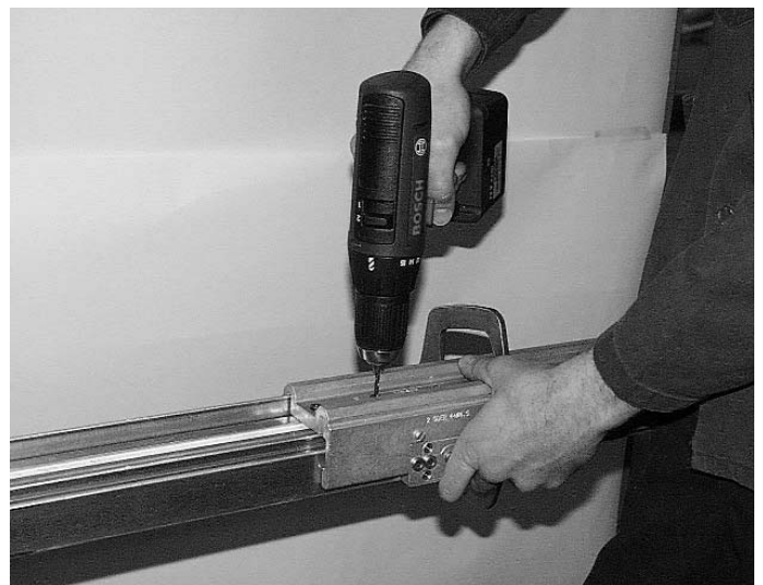
Abb. 1 Hauptschloss Fig. 1 Serrure principale
