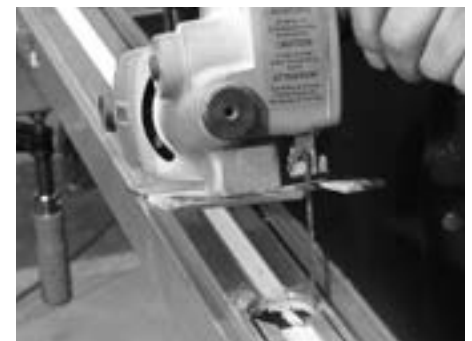
Ausnehmung mit Stichsäge ausschneiden Découpage de l'évidement avec un scie à guichet Cut out the recess using a jigsaw
